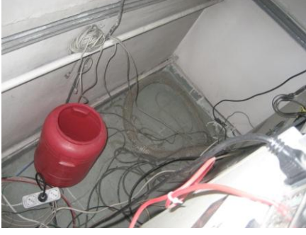
Şekil 7. Açıkta kablolar bulunmaktadır.
