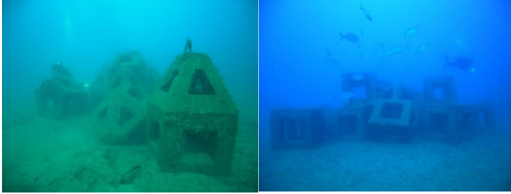
Şekil 2.2. Ürkmez ve Gümöldür kıyılarında bulunan yapay resif blokları
