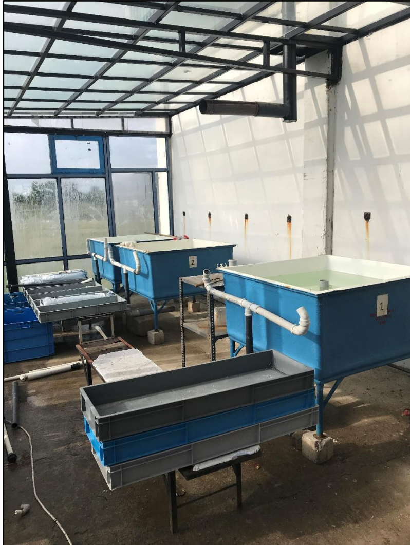
Şekil 3.4. Akuaponik ünite içerisindeki balık tankları ve bitki yatakları.
