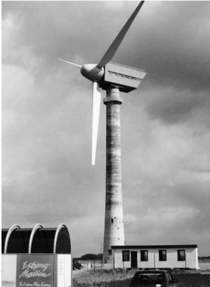
Şekil 5.10. Betonarme kule (Açık, 2010).
