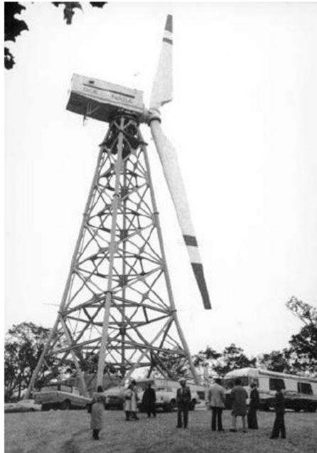
Şekil 5.9. Kafes yapılı kule (Açık, 2010).
