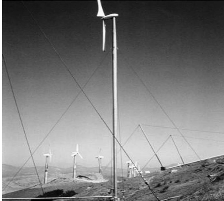
Şekil 5.11. Gergili çelik kuleler (Açık, 2010).
