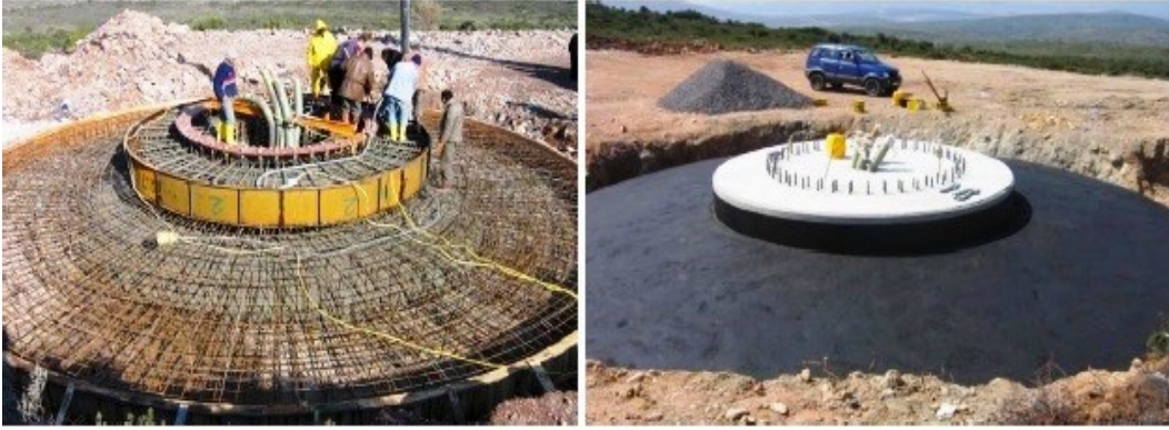
Şekil 6.2. Rüzgar türbini zemin yapısı (Uysal, 2008).
